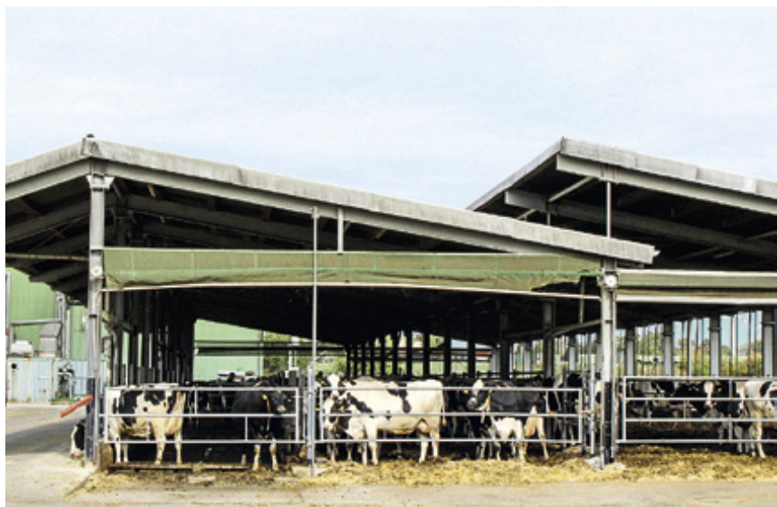
Die Trockensteher sind in einem neu gebauten Strohstall untergebracht. Die Kühe werden einphasig zur Kalbung hin gefüttert.
